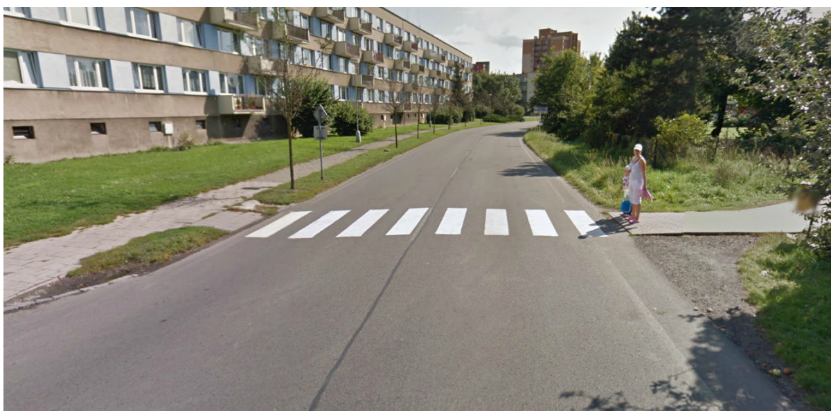
Současný přechod pro chodce
