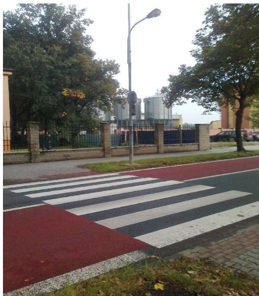
Stávající přechod u gymnázia
