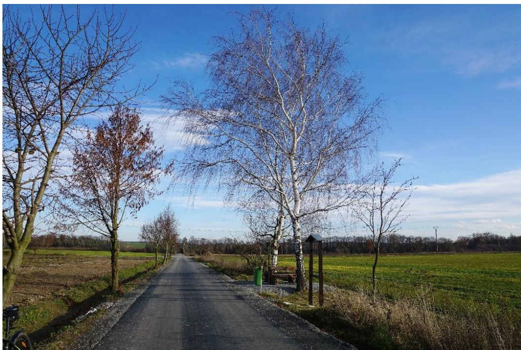
Obr. 7 Opravená „Prajzská cesta“ – Bohuslavice - Bolatice
