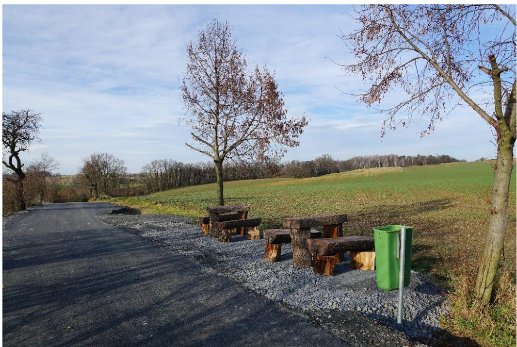
Obr. 6 Opravená „Prajzská cesta“ – Bohuslavice - Bolatice
