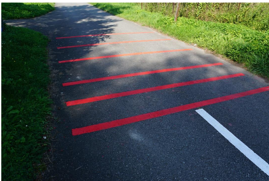
Obr. 14 Řešení nepřehledné zatáčky Chalupki – výstražné červené pruhy
