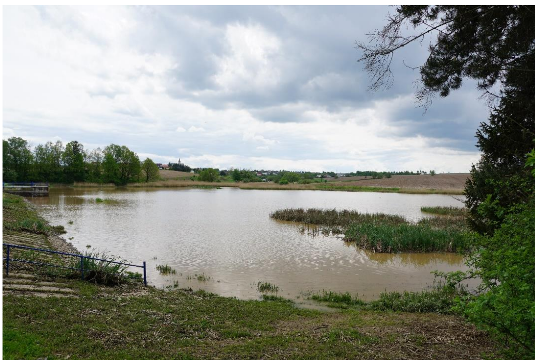
Obr. 10 Retenční nádrž na potoku Bečva v Hatí
