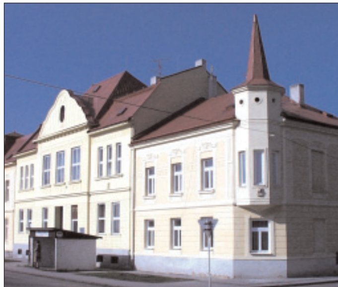
▲ Adaptovaná budova na ul. 1. máje v městské části Skřečoch, v níž sídlí pošta a pobočka městské knihovny.
