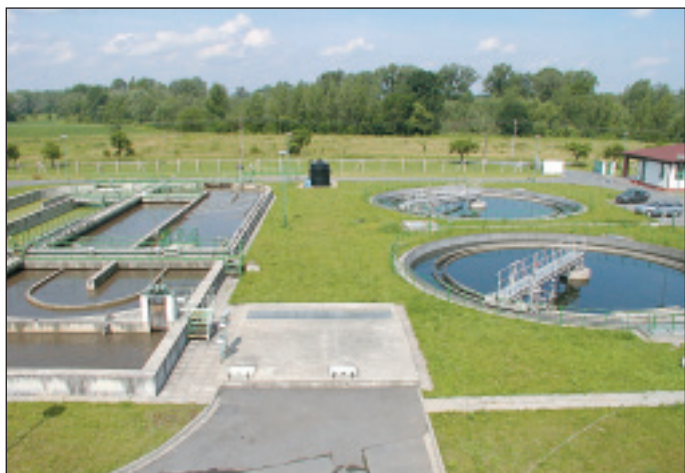
▲ Výstavba čistírny odpadních vod v Šunychlu byla dokončena v roce 1999 polskou firmou Budimex.
