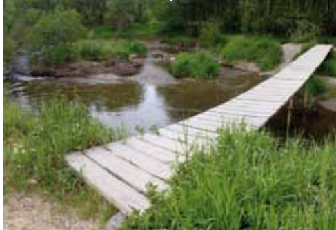
km 90,07 – kładka na lewym ramieniu
