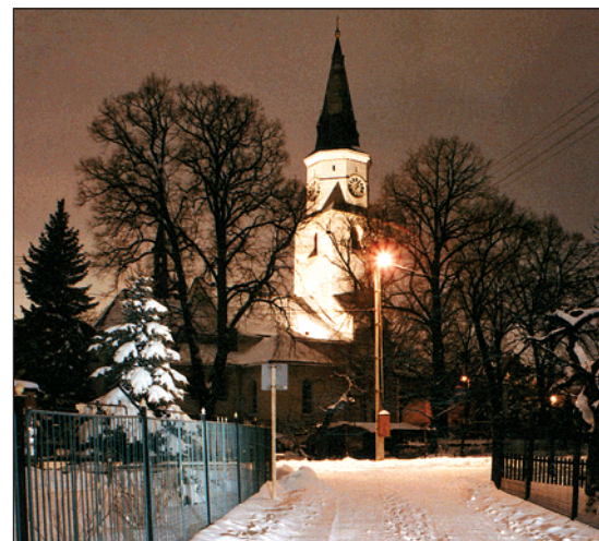
▲ Řada památek je opravena, některé jsou i nasvíceny, jako kostel Narození Panny Marie ve Starém Bohumíně.
