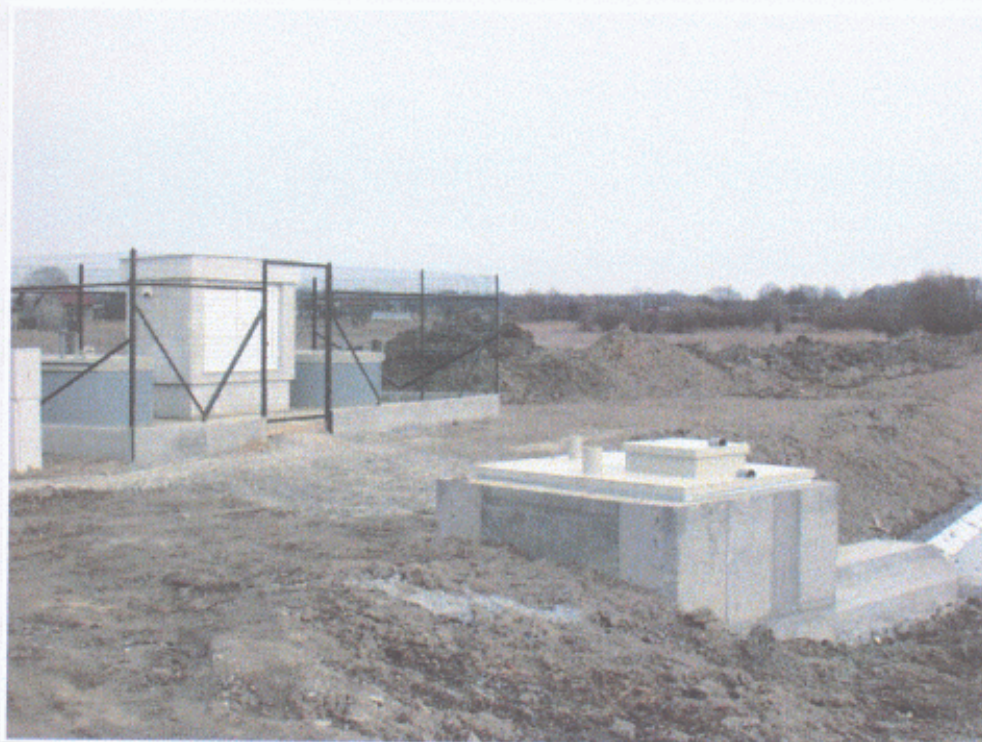
Nově budovaný systém odvodňování m.č. Skřechův- Nová Ves bude letos i nadále pokračovat.
