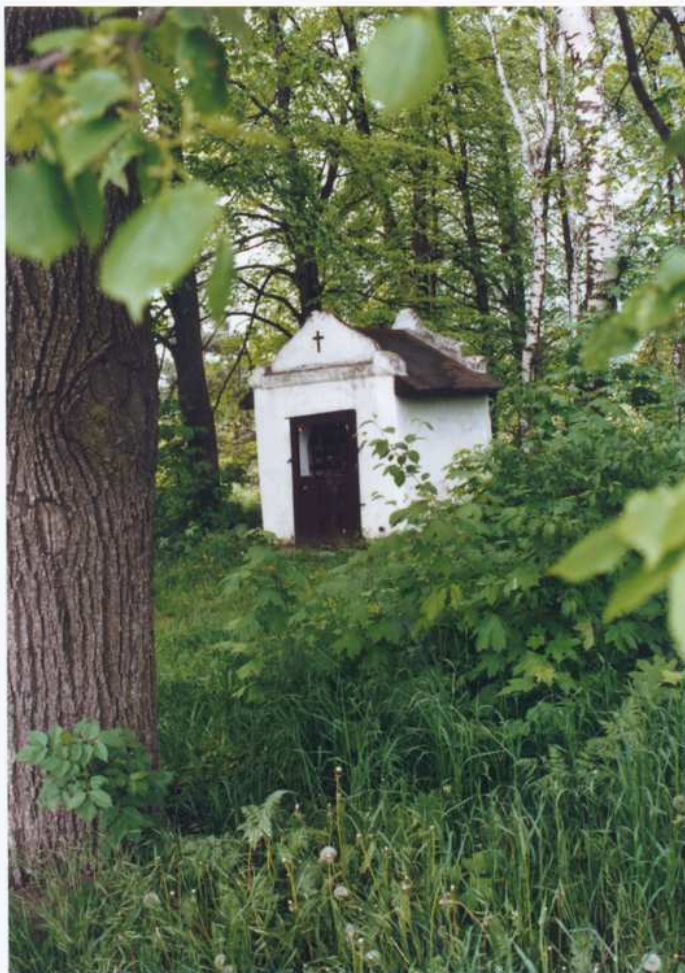
Snímek bývalé epidemiologické kaple ve Starém B. před její opravou.
