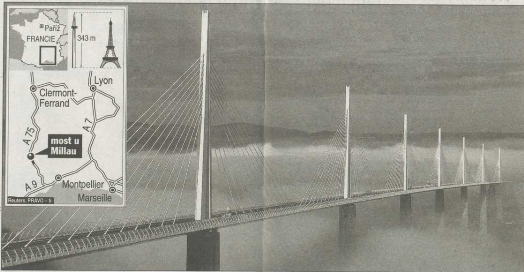
Celkový pohled na monumentální most, který překlenuje údolí řeky Tarn u jihofrancouzského města Millau.
