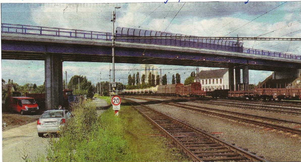
Zcela nový most postavili stavbaři ve Studénce za sedm měsíců.
