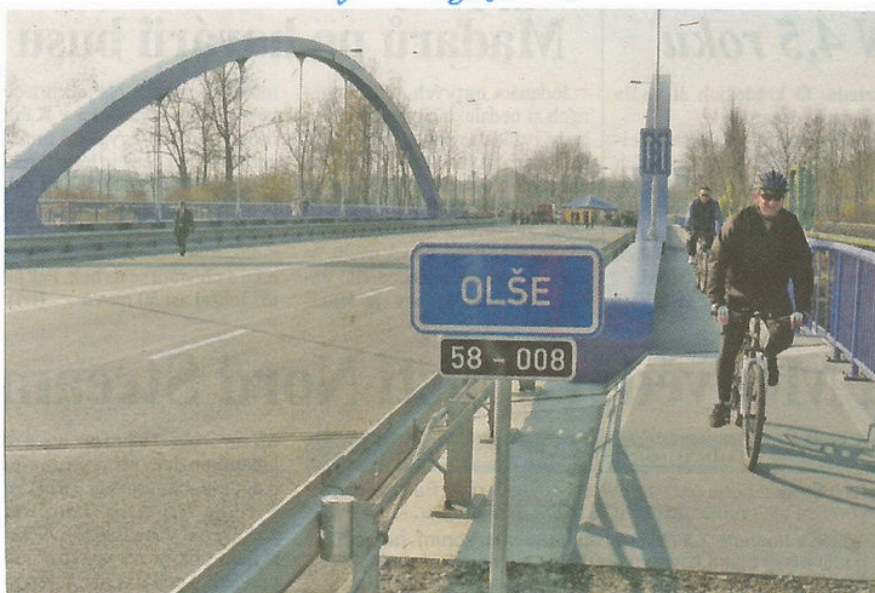
KONEC KOLAPSŮ. Půlroční martyrium tisíců řidičů z Karvinska skončilo o půlnoci ze soboty na neděli. Ředitelství silnic a dálnic (ŘSD) totiž dokončilo nový most přes řeku Olši, po kterém vede do Karviné příjezdová cesta od Ostravy. Původní most museli dělníci zbourat letos na jaře, neboť jeho pilíř těžce poškodila loňská povodeň. Za stavbu nového mostu, který je 134 metrů dlouhý a váží 710 tun, zaplatilo ŘSD 180 miliónů korun. (plk)
