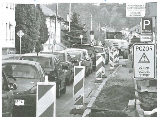
Stroje stavební blokuji ulici 1. máje a způsobují zácpy.
