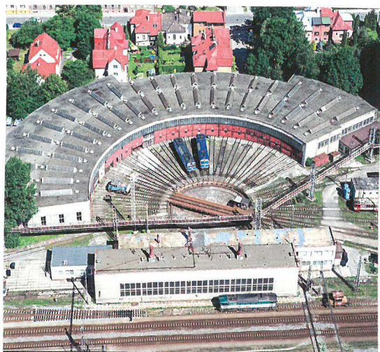
Jako vějíř vypadá z ptáčích perspektiv rotunda s železniční točnou v areálu ČD Bohumín. Budova slouží k opravám lokomotiv.
