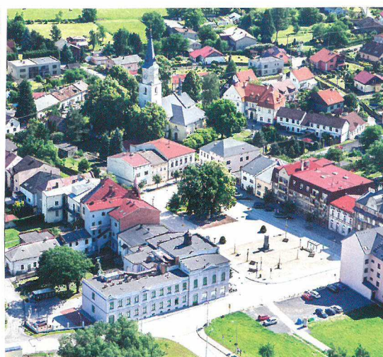
Pohled na zrekonstruované náměstí Svobody ve Starém Bohumíně a opravený dům Pod Zeleným dubem.
