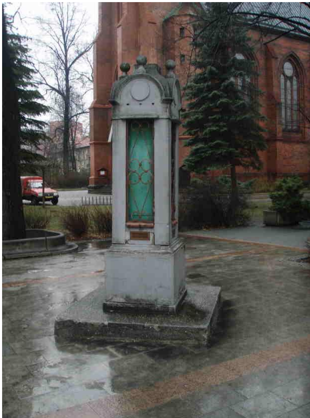
Celkový pohled na stav meteo sloupku ze strany A před zahájením oprav.
