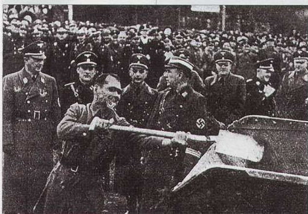
Zahájení výstavby Sudetské dálnice u Chebu za účasti Rudolfa Hesse 1. prosince 1938
