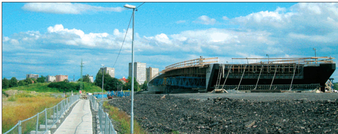
Stavba nadjezdu dálnice D 47 spojujícího Slezskou ulici se Starým Bohumínem (pohled od Starého Bohumína).
