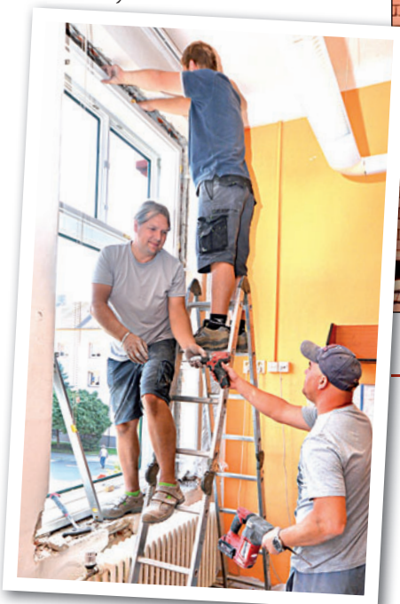
Po vyčištění zadní fasády došlo také na výměnu oken. Ta jsou věrnými replikami původních, pouze mají navíc izolační dvojskla. Foto: Pavel Čempěl
